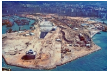
當年西區海底隧道的通風大樓(圖左下建築物)，用作通風抽氣。(照片由受訪者提供)
